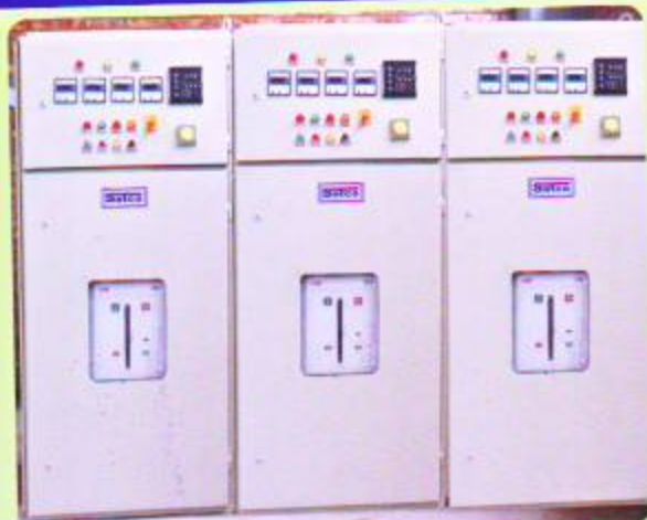
HT Switchgear
